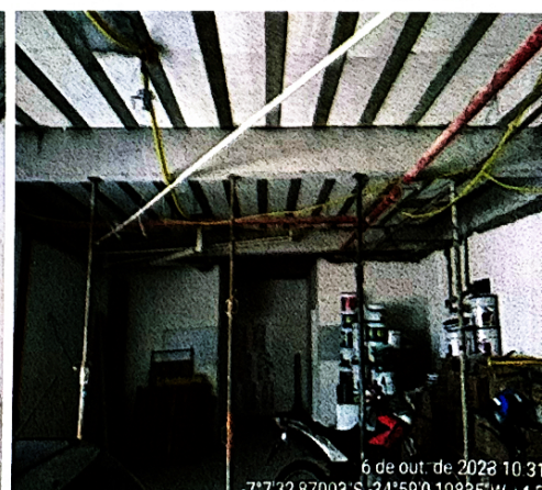
Registro Fotográfico (Figuras 06, 07 e 08): Construção do Pronto Atendimento Infantil (Viga com escoramentos) Fonte: Juan Ébano/2023
